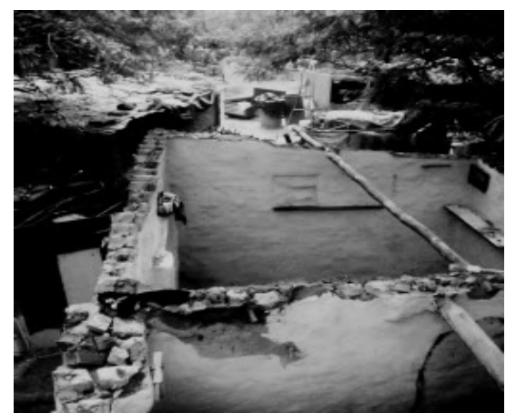
गुरुग्राम : निर्माण मजदूरों की टूटी हुई झुग्गियाँ
